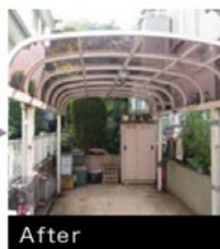
【カーポート】 強風で割れてしまったカーポートを全て外して骨組みだけになりました。新しいポリカーボネートをはめて、カーポートの修理は完了です。
