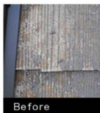
【板金屋根】 雪害によって痛んだ板金及び貫板を総交換し、雨樋部分も交換しました。
