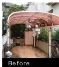
【カーポート】 強風で割れてしまったカーポートを全て外して骨組みだけになりました。新しいポリカーボネートをはめて、カーポートの修理は完了です。
