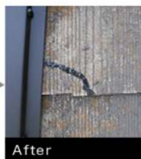
【板金屋根】 雪害によって痛んだ板金及び貫板を総交換し、雨樋部分も交換しました。
